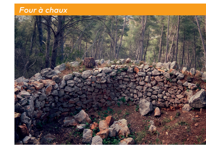
Four à chaux
