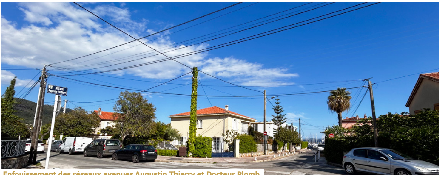
Enfouissement des réseaux avenues Augustin Thierry et Docteur Plomb
